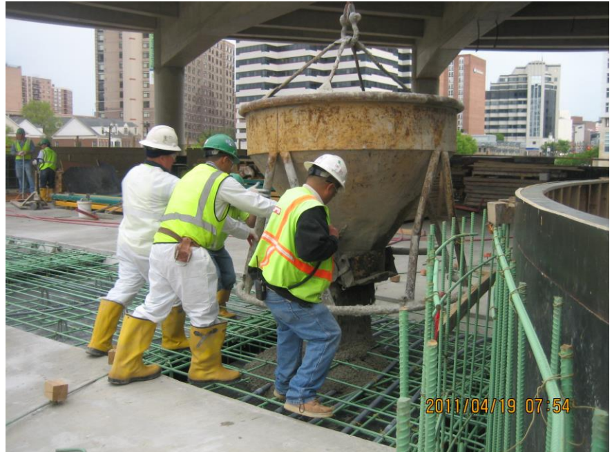
Image 6: West Level 330 Pour Strip Concrete Pour – April 19, 2011
