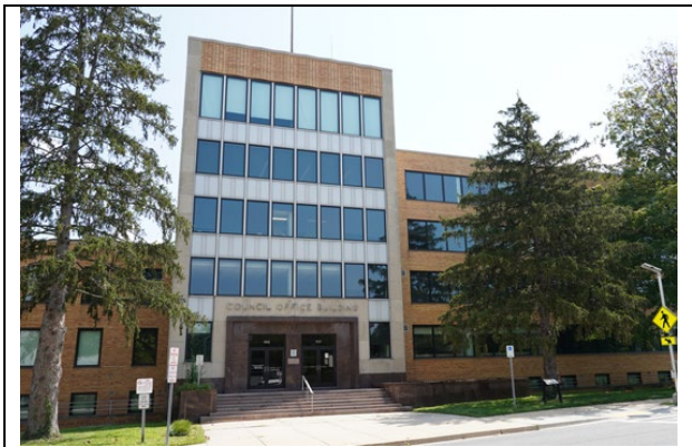
በዕድሳት ወቅት በሜሪላንድ አውራ ጎዳና ላይ የሚገኘው የካውንስሉ ጽህፈት ቤት ሕንፃ መግቢያ በር።
