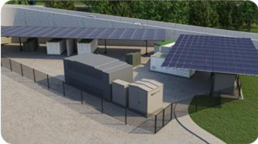
2. 2 MW / 6.88 MWh BESS
